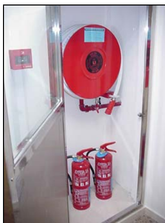
Bocas incendio equipadas y extintores
