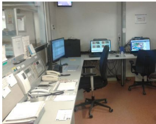
Central de señalización y control
