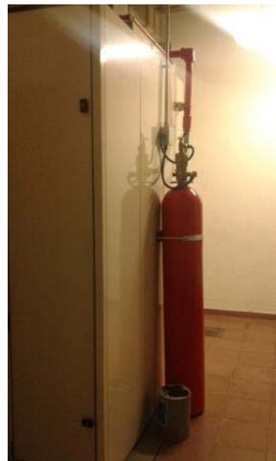
Instalación de baja tensión (sistema de extinción de NOVEC)
