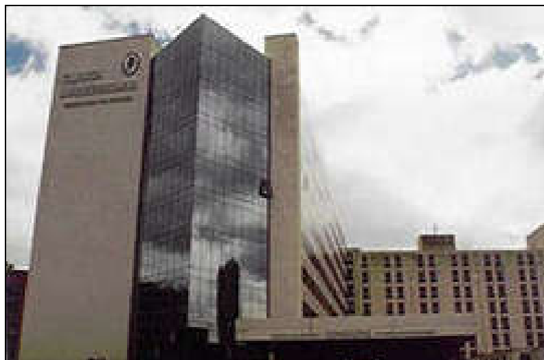
Vista general Clínica Universidad de Navarra (III y IV fase)
