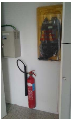
Armario zona nueva laboratorios (II fase)
