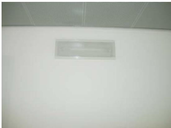
Bloques autónomos iluminación emergencia
