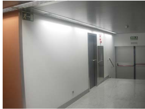
Señalización de vías evacuación
