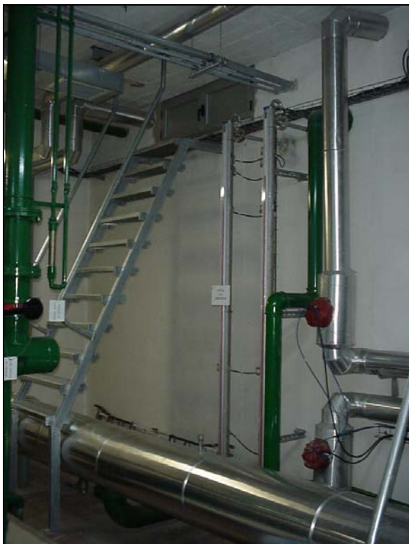
Depósitos de agua
