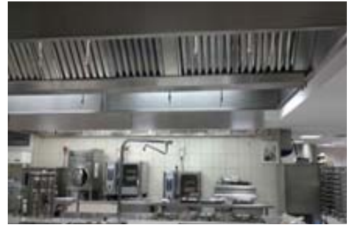
Campanas del Serv de dietas y Serv de cafetería (Sistema automático de espuma)
