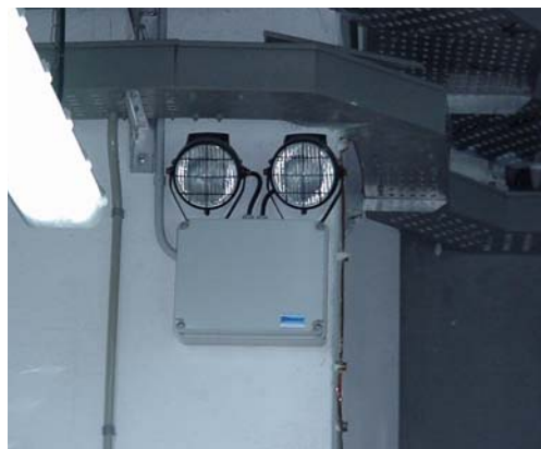
Focos especiales alumbrado emergencia
